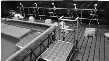
自衛隊風呂に、簡易置き型手すりを設置
